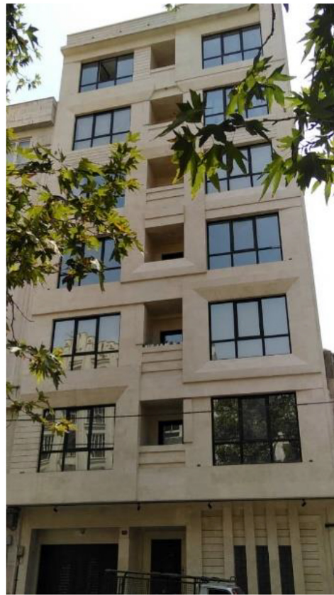
تصویر نمای اصلی ساختمان مجاور چپی ۱
