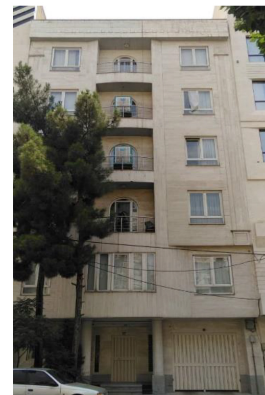
تصویر نمای اصلی ساختمان مجاور چپی ۲
